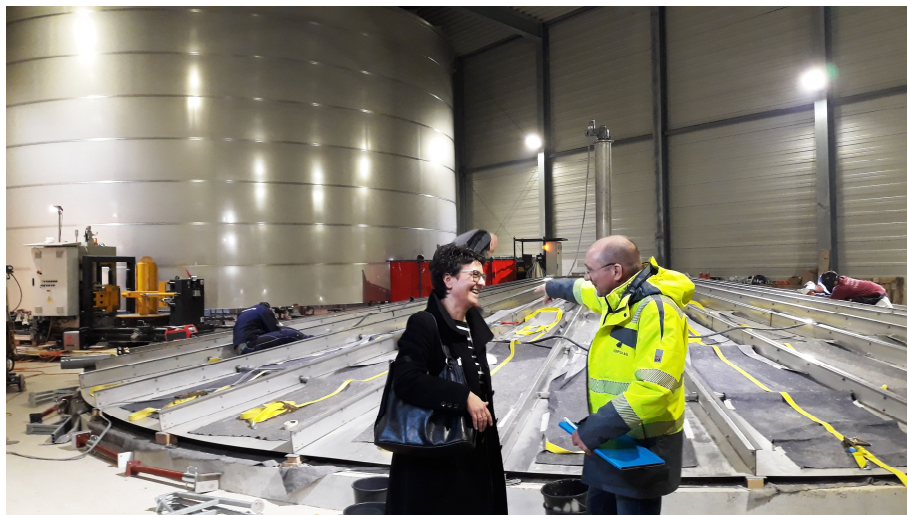
Bürgermeisterin Andrea Ernhofer auf der Baustelle des Hochbehälters am Fortberg
