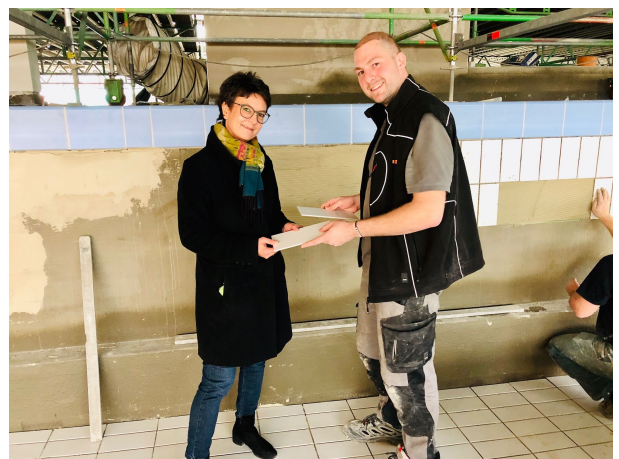
Bürgermeisterin Andrea Ernhöfer auf der Hallenbadbaustelle. Das große Becken wird gefliest.
